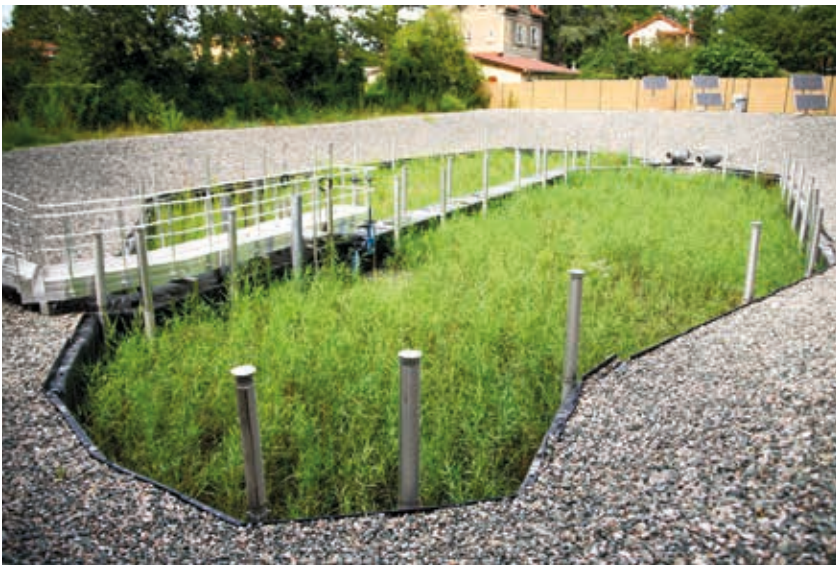
Filtre végétalisé pour la gestion et traitement des surverses de déversoirs d'orage à Marcy l'Etoile (69).
